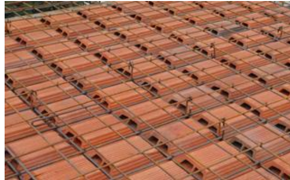
Fig. 3 Filler Slab
